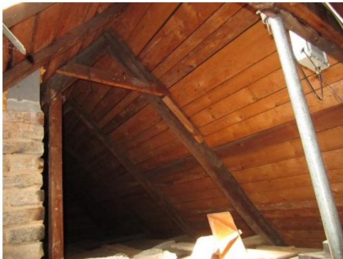
Pohled do půdního prostoru rodinného domu
