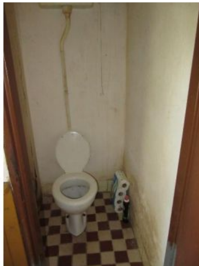
Pohled do interiéru rodinného domu - WC v přízemí
