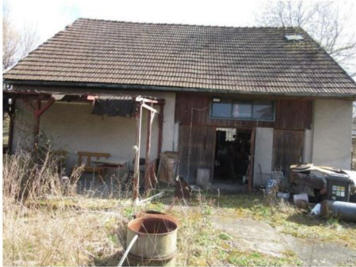
Pohled na vedlejší stavby - na stodolu od severu
